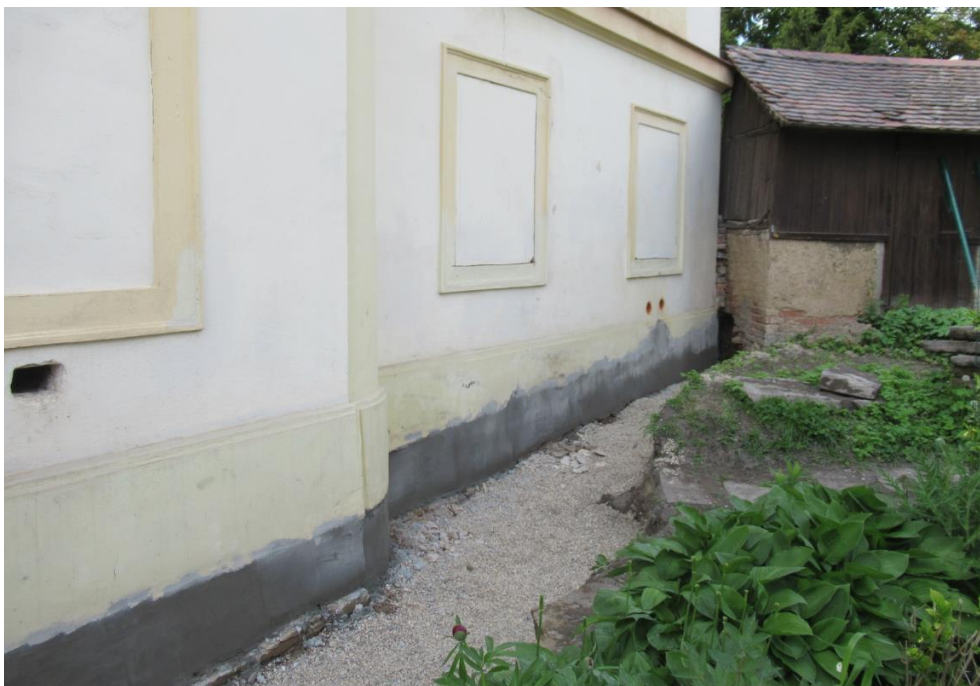
Oprava soklu pod úrovní upraveného terénu
