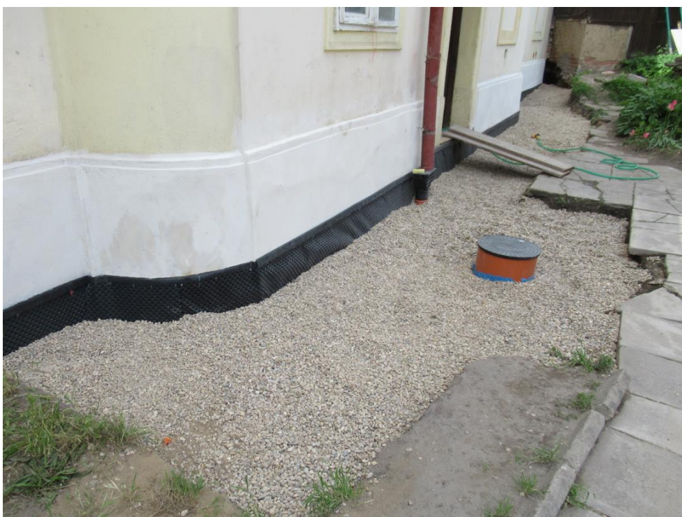
Podklad pod novou dlažbu před vstupem
