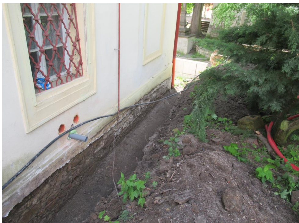
Výkopové práce před sanací soklu a položení drenáže
