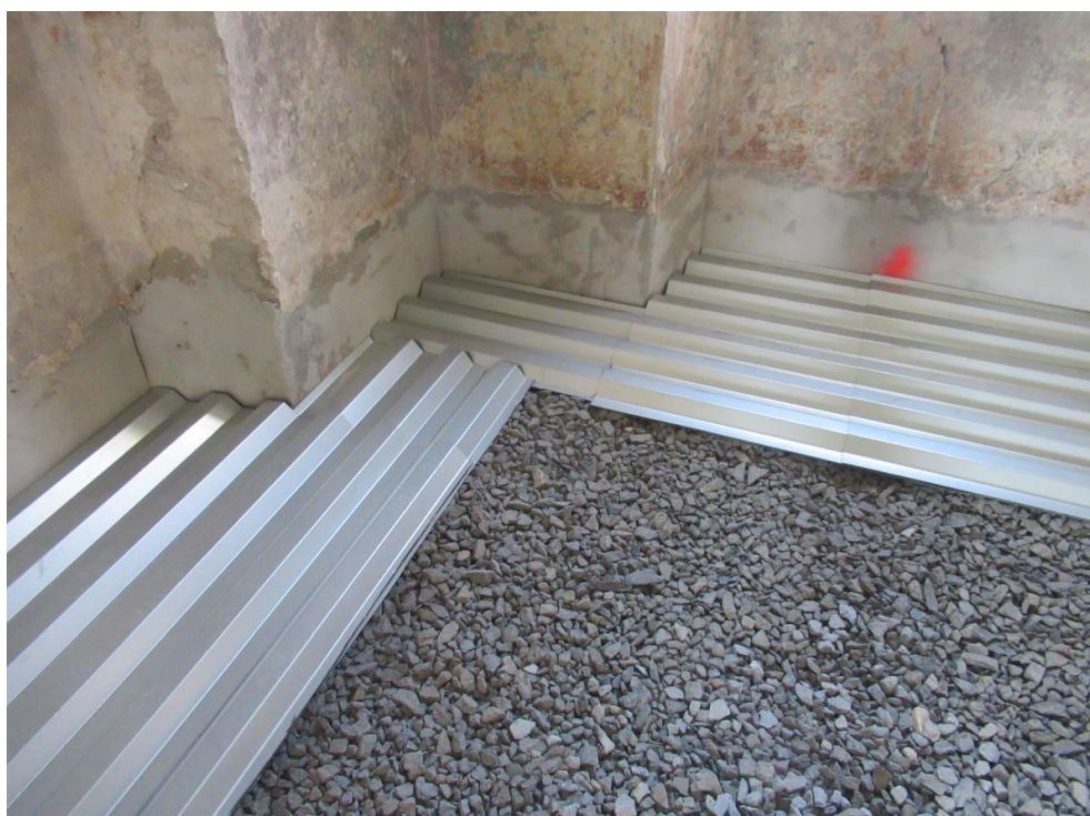
Zakrytí vzduchového kanálu před betonáží
