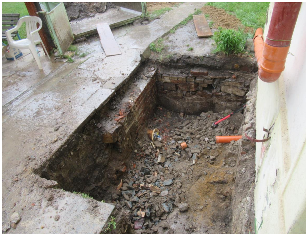
Vybourání staré přípojně šachty splaškové kanalizace
